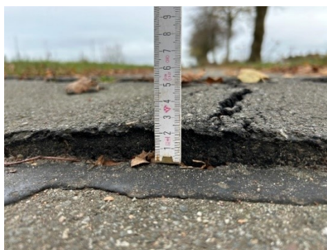
Wurzelaufbruch im Bereich der Gemeinde Pohnsdorf mit einem scharfen Höhenversatz von 2,5 cm (04.11.2024, Quelle Gemeinde Pohnsdorf)
