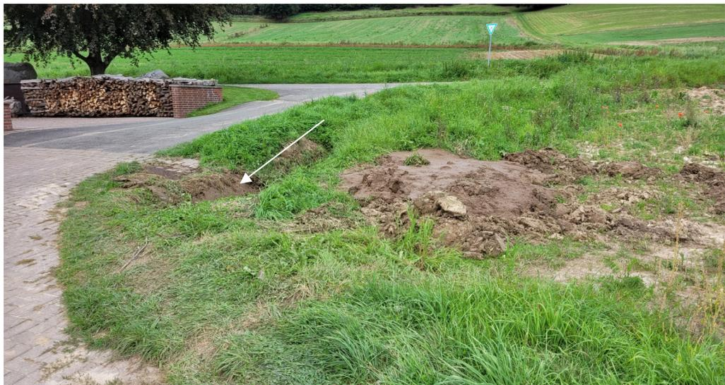
Abbildung 8: Einlauf Verrohrung (Pfeil) (hier mit ausgebaggertem Erdmaterial nach dem Starkregeneignis) und vierzeilige Rinne (links)
