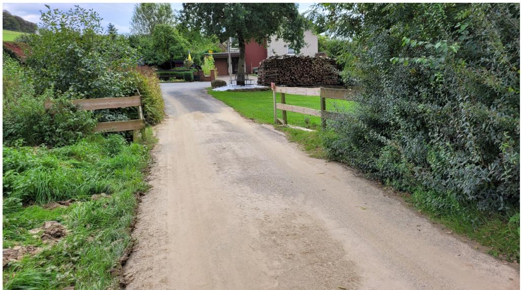
Abbildung 13: Spuren der Überströmung der Kreuzung des Haddesser Baches mit der Straße „An der Katzennase“ bei einem Starkregenereignis; links hoher Bewuchs vor dem Durchlass
