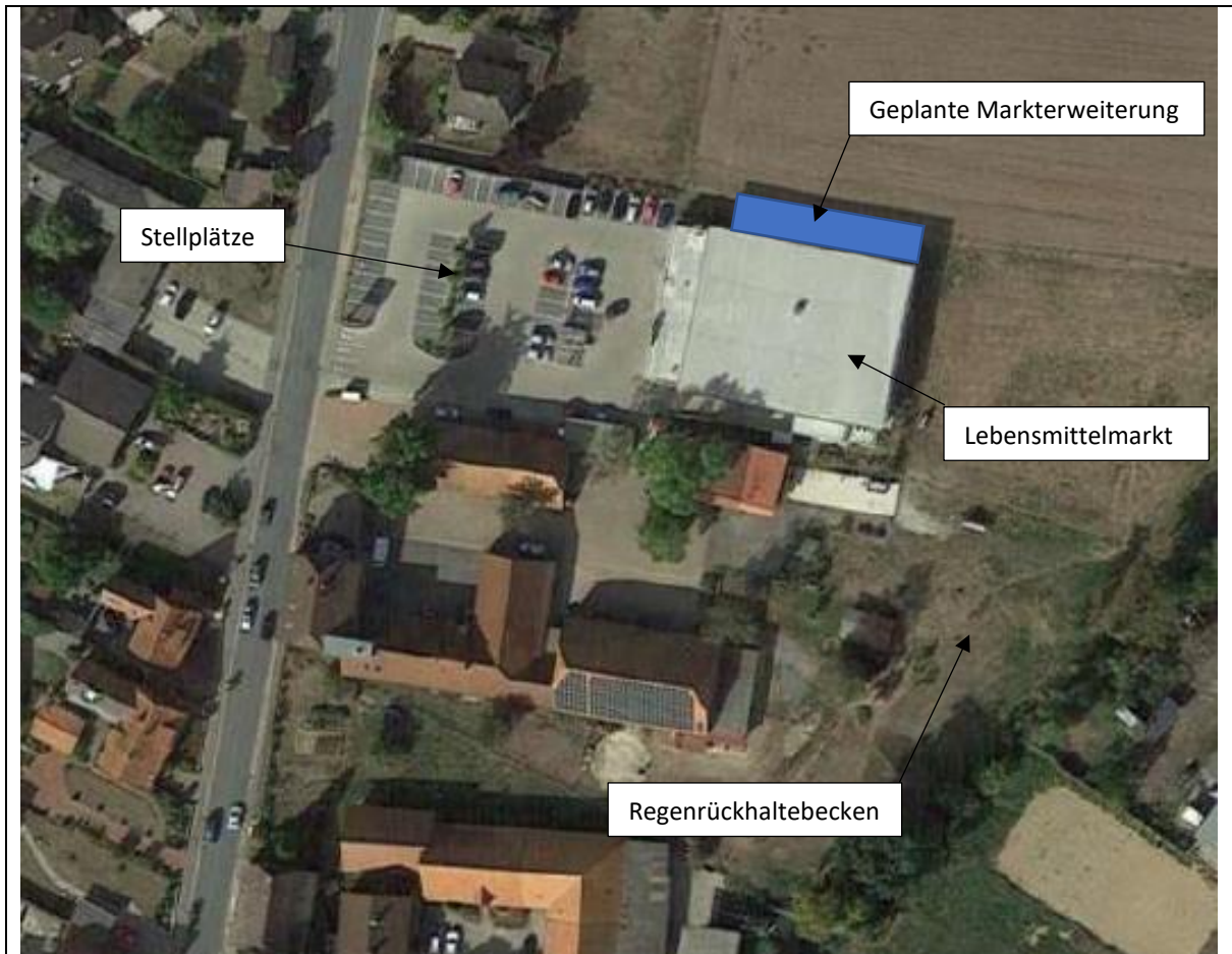
Luftbild des Plangebiets und der unmittelbaren Umgebung mit Darstellung der geplanten Erweiterung
