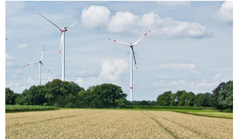
Windpark mit WEA mit 200 m Gesamthöhe
